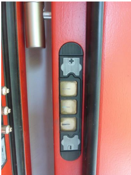
Abbildung 16: Motorschloss, Pflege der Kontakte
