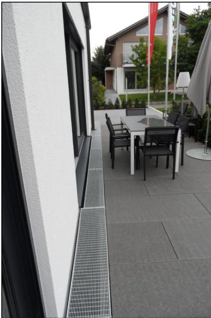
Abbildung 26: Beispiel Gitterrostauführung bei Terrasse
