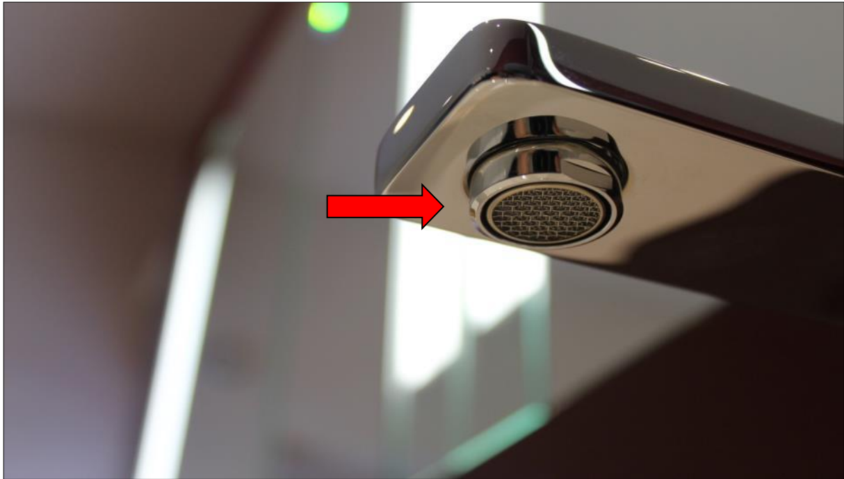
Abbildung 9: Wasserstrahlregler - Einkerbungen für Strahlreglerschlüssel erkennbar
