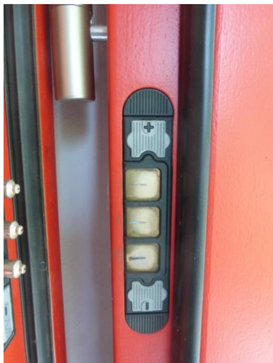
Abbildung 14: Motorschloss, Pflege der Kontakte
