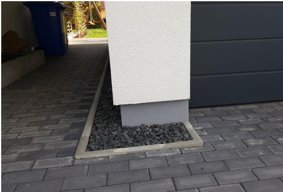
Abbildung 29: LUXHAUS Sockeldetail 14 - LUXHAUS Garage mit Betonaukantung
