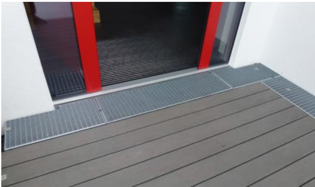
Abbildung 27: LUXHAUS Sockeldetail 8 - Hauseingang mit Rinne
