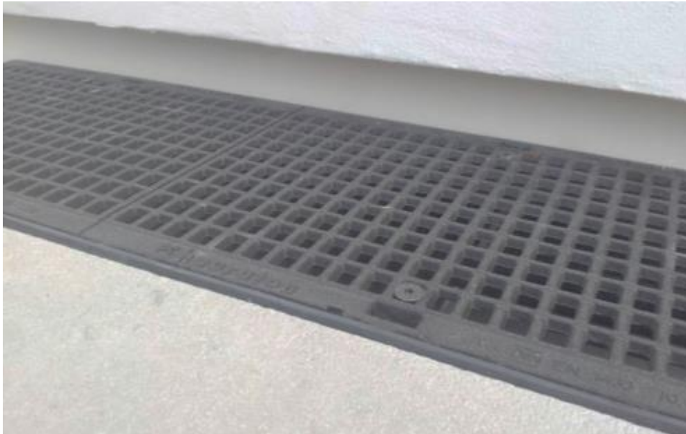
Abbildung 21: LUXHAUS Sockeldetail 3 - Sockel \geq 5 cm mit Rinne
