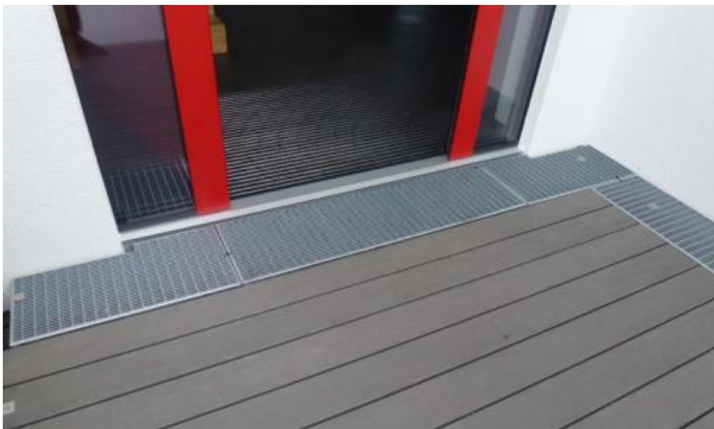
Abbildung 26: LUXHAUS Sockeldetail 7 - Hauseingang mit Kiesbett
