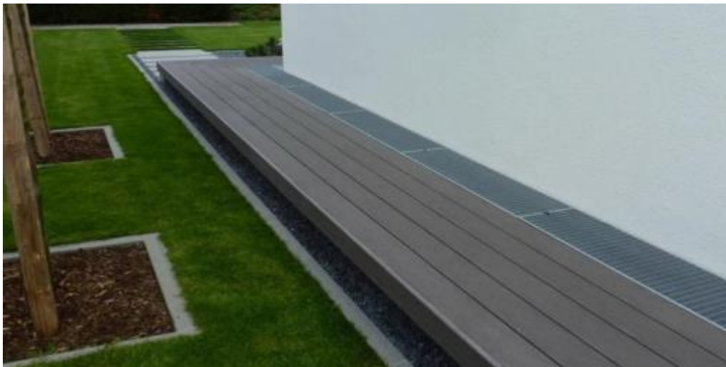
Abbildung 23: LUXHAUS Sockeldetail 5 - Terrassenbereich mit Holzbelag
