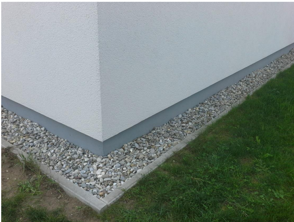
Abbildung 19: LUXHAUS Sockeldetail 2 - Sockel \geq 15 cm mit Kiesstreifen
