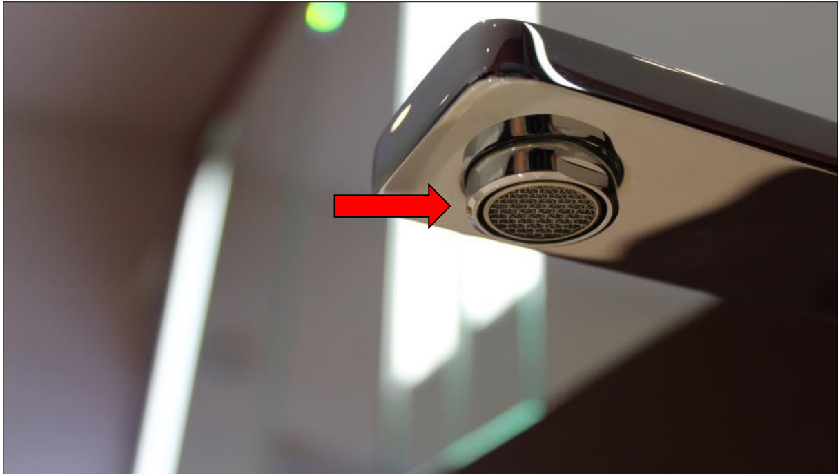
Abbildung 6: Wasserstrahlregler - Einkerbungen für Strahlreglerschlüssel erkennbar
