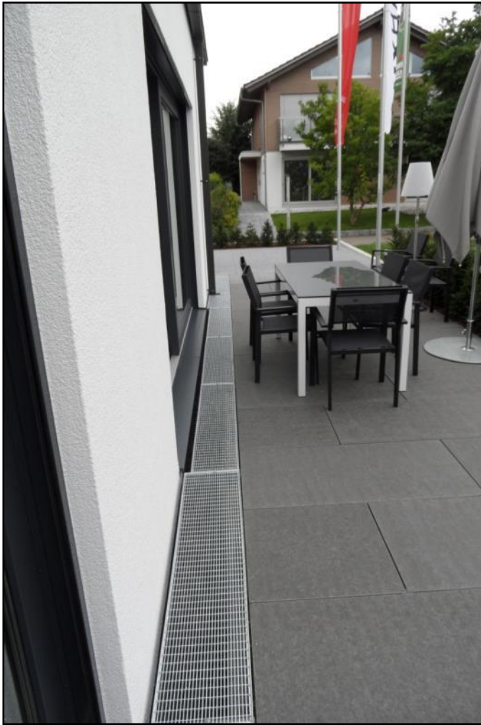
Abbildung 39: Beispiel Gitterrostausführung bei Terrasse
