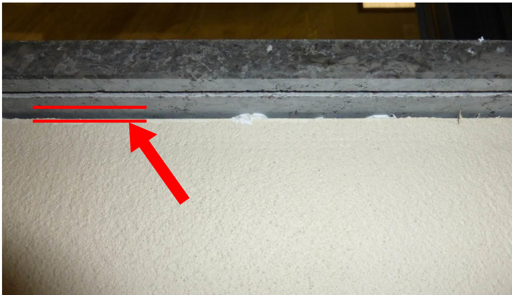
Abbildung 17: Fuge unter Fensterbank
