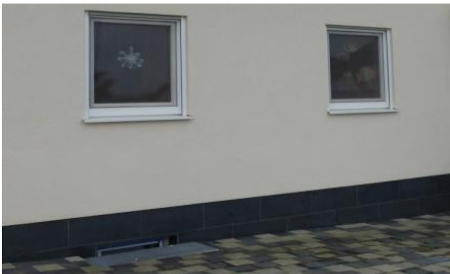
Abbildung 18: LUXHAUS Sockeldetail 1 - Sockel \geq 30 cm
